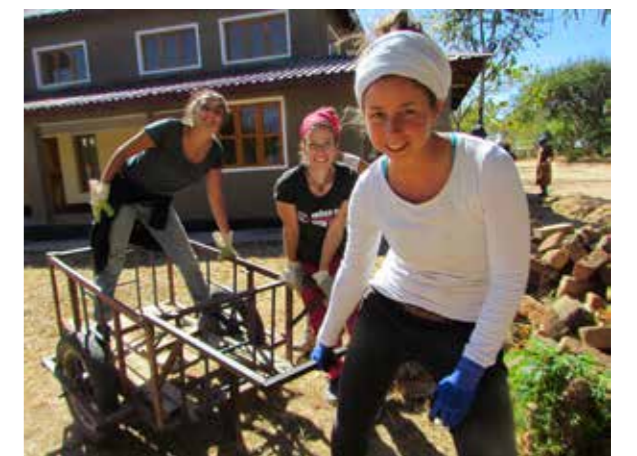
Errichtung von 3 Wasserspeichern in der Partnerpfarre Luduga in Tansania; Pfarre St.Josef/Baden
